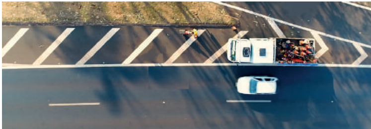
Implantação/Retirada de Sinalização com Veículo de Proteção (veículo de serviço)
