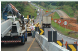
Figura 33 - Exemplo de Barreira provisória para separação de fluxo bidirecional em desvio
