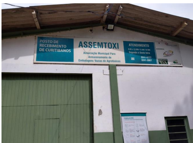
Figura 29 - Galpão da ASSEMTOXI.
