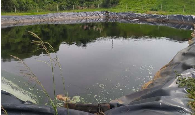
Figura 37 - Manta impermeável da lagoa de estabilização de forma regular.
