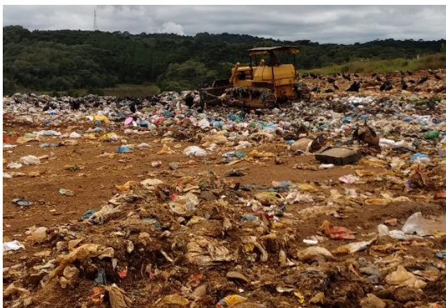
Figura 41 - Trator realizando a compactação.
