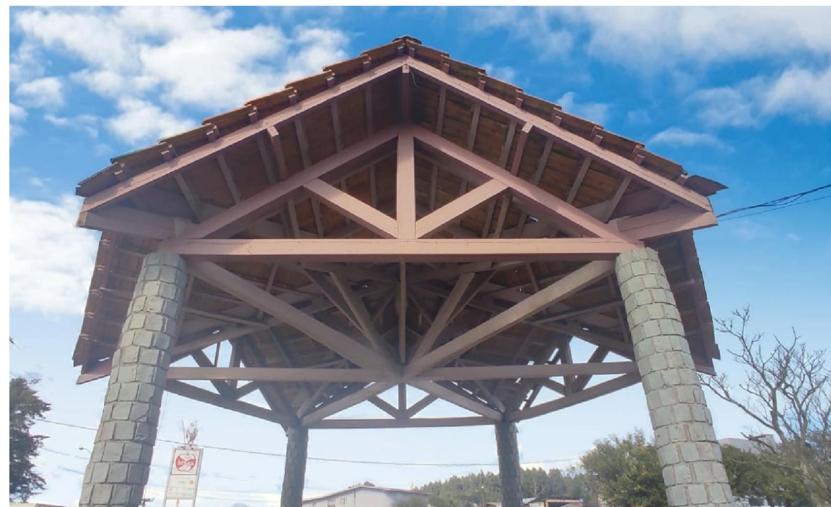
F1 FOTO DA COBERTURA A REMOVER ESC. 1/50
